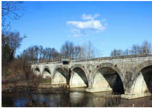
Pont de la voie ferrée sur l'Avène
