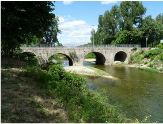
Pont sur l'Avène – RD 981 Route d'Uzès
