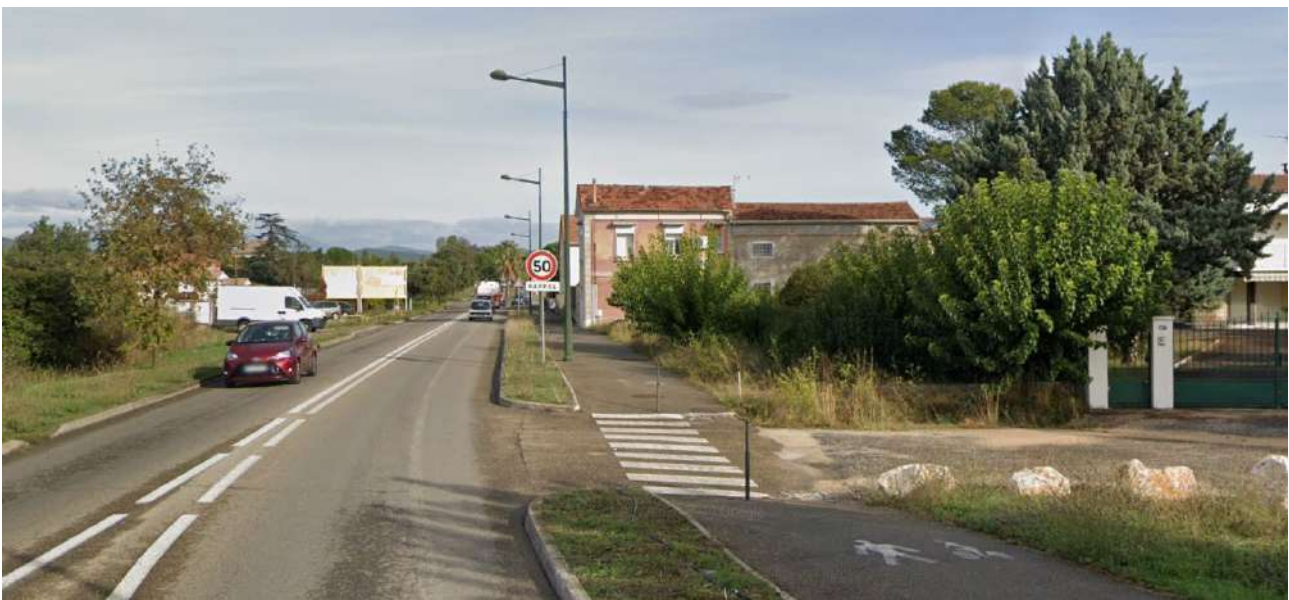
Exemple d'aménagement cyclable réalisé par l'agglomération le long de la RD 936
