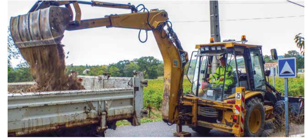
Un moment important dans l'année le curage des fossés en prévention des fortes pluies.
