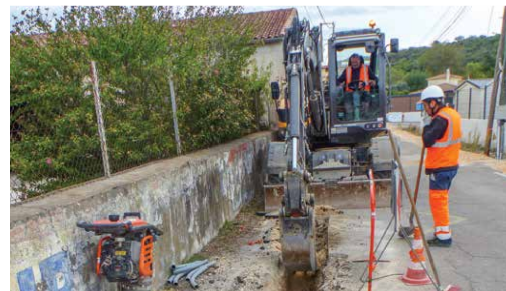
Les travaux à la Burgerine commencent avec l'enfouissement des réseaux secs.
