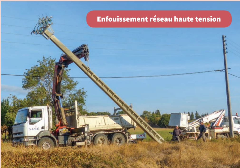
Chantier de renforcement et d'enfouissement du réseau électrique par ERDF Grâce à l'initiative de la mairie, ERDF a enfoui 9119 mètres de lignes électriques.
