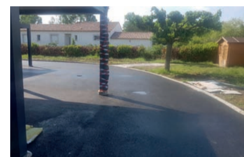
Enrobé de la cour de l'école
