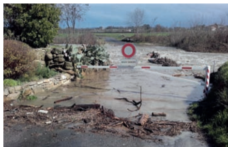
Barrière secteur du pont de Tribies
