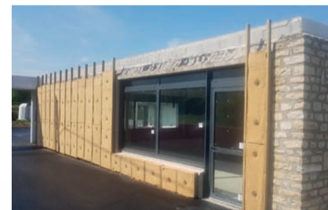
Isolation extérieure en panneaux laine de bois
