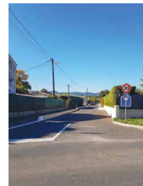
Impasse des Vabres : enrobé et voies douces.
