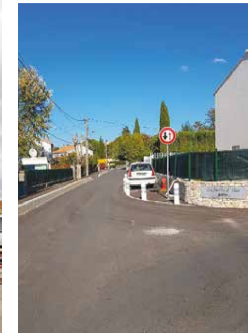
Réfection de la route chemin de Saint-Hilaire à Larnac
