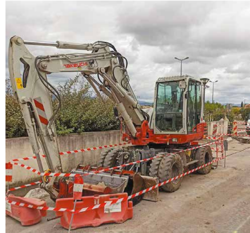
Création d'un réseau tout à l'égout en séparatif sur l'intégralité du chemin du stade.
