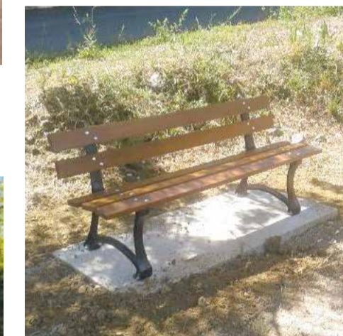
Chemin de la Bugadière, mise en place d'un banc...
